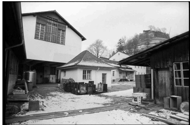
«Saubere Sache» ist nämlich im einzigen übrig gebliebenen Gebäude der ehemaligen Seifi Lenzburg zu sehen.
